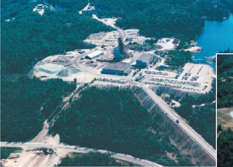
Photo de la mine Quirke II, Rio Algom Limited Elliot Lake, Ontario avant la remise en état.
