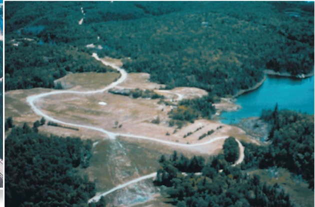
Photo de la mine Quirke II après l'enlèvement des bâtiments et avant le réensemencement et la plantation.
