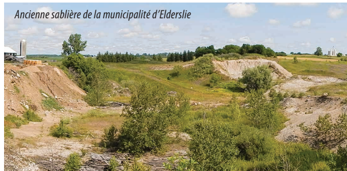
Plus de 31 000 m 3 de matière ont été déplacés pour créer une pente adoucie à angle de 8:1 aux fins d'exploitation agricole
