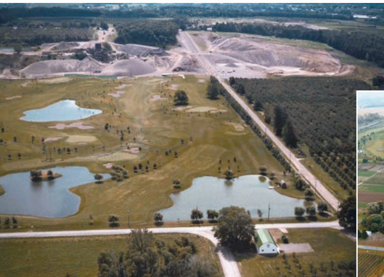
Photo de la carrière de Fonhill, Steel and Evans Limited, pendant la remise en état à Fonhill, Ontario.
